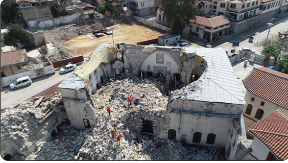
Görsel 1.41: Depremde yıkılan Habib-i Neccar Camisi / Hatay
