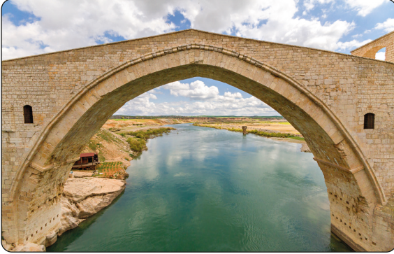
Görsel 1.8: Malabadi Köprüsü / Diyarbakir
