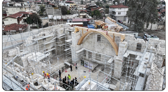
Görsel 1.42: Habib-i Neccar Camisi'nin restorasyonu
