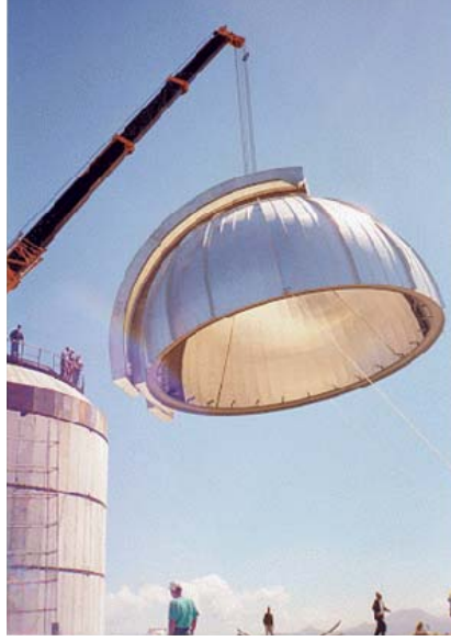
150 cm ayna çaplı teleskop binasının kubbesinin yerleştirilmesi
